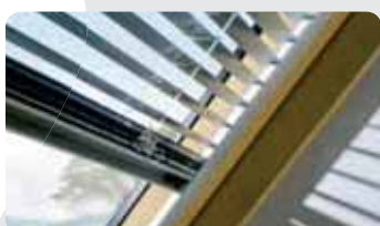
Aluminiowe prowadnice pozwalają na pełniejsze zaciemnienie wnętrza i utrzymanie lamelek w linii
